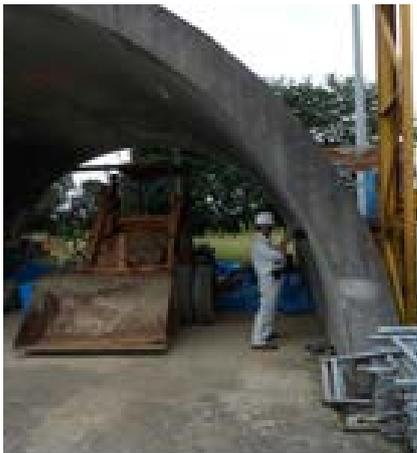
写真6 側壁部・覆工コンクリート探査の探査
